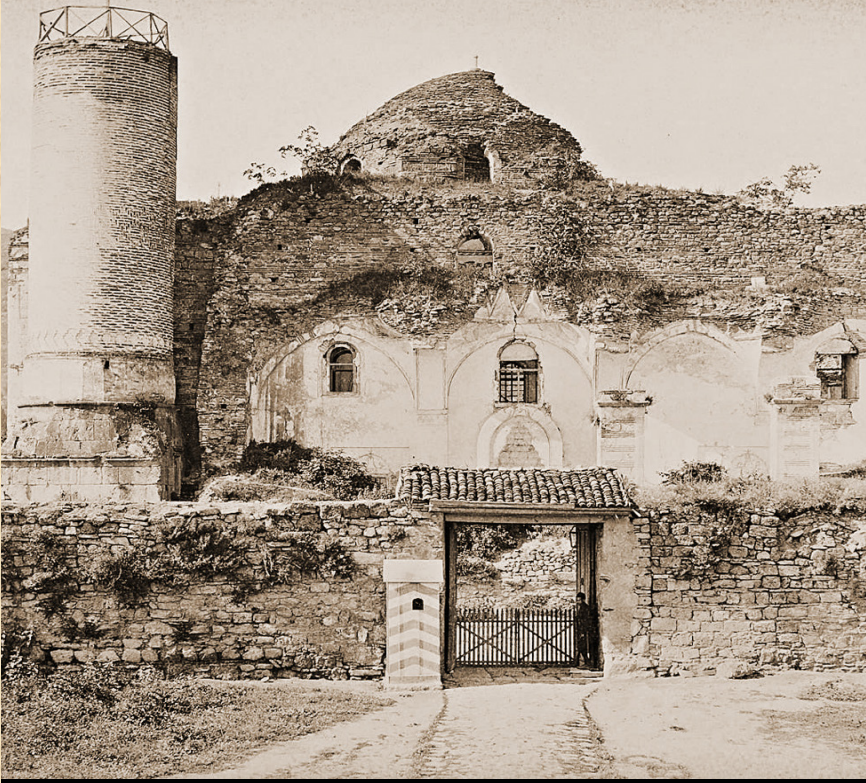
1855 Bursa Depremi'nden sonra harap olan Şehadet Camii
