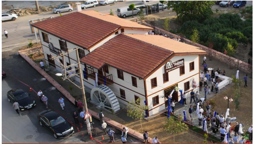
Gürsu'da şu an tesis olarak işletilen eski değirmen
